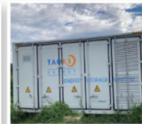
所在地: 宮崎県 蓄電池容量: 860kWh 用途: 低圧過積載(蓄電池併設) 稼働時期: 2022.6
