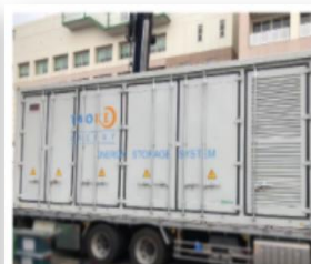
所在地: 熊本県 蓄電池容量: 1505kWh 用途: ピークカット+BCP 稼働時期: 2022.6
