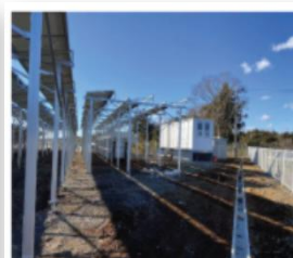
所在地: 茨城県 蓄電池容量: 1290kWh 用途: 自家消費 稼働時期: 2021.12
